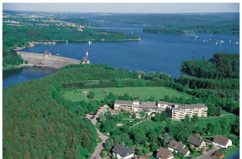
Heinrich-Lübke-Haus in Günne - im Hintergrund die Mohnetalsperre
